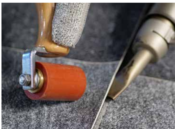
Soldadura mediante solape
