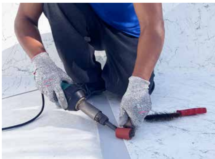
Soldadura a testa
