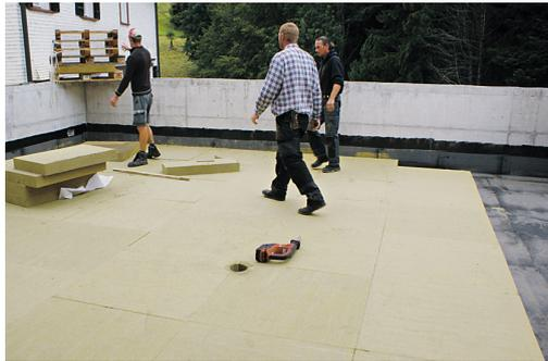
Trittfeste Dämmplatte für den Einsatz in Flachdächern, welche für eine Nutzung durch Personen und/oder für Installationen vorgesehen sind. Auch als Gefälledachlösung erhältlich.
