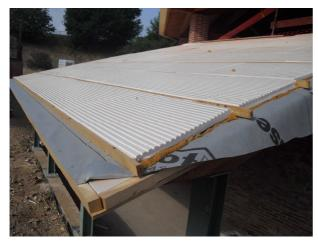
Para a fixação das telhas, será utilizada camada de argamassa ou espuma de poliuretano ALSAN FOAM MF
