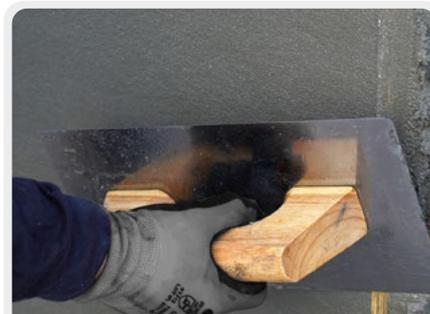
**2** Aplicación del material en capa gruesa (10 mm) mediante llana.
