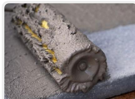
**2** Aplicación de la 1ª capa del material (1 mm) mediante brocha, rodillo o llana.
