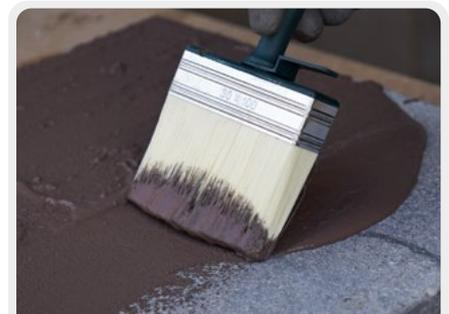
**2** Aplicación de la **1ª capa** del material (1 mm) mediante brocha o llana.
