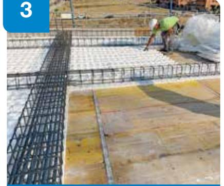
Colocación del tablero SOPRAEPS en las cuadrículas restantes que ha marcado la placa SOPRAEPS en toda la superficie. El ajuste de medidas y recortes se realiza con serrucho o radial.
