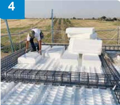
Colocación de la bovedilla-casetón SOPRAEPS TECOWOB sobre los tableros SOPRAEPS.
