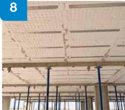
Retirada a los 7 días de los tableros de madera del encofrado inicial, a excepción de las sopandas (punto 1).
