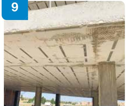
Si el sistema colocado es SOPRAEPS, disponer de las omegas inferiores y utilizar horquillas recomendadas para fijar directamente el techo descolgado de PYL.
