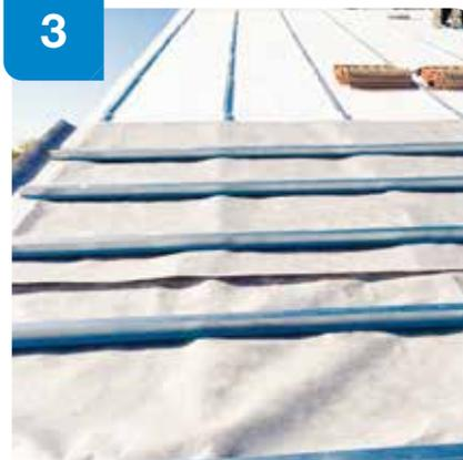
Colocar las omegas secundarias en posición horizontal con la distancia entre ellas del paso de teja a utilizar.
