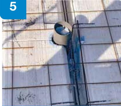
Colocación de mallazo, redondos, aviones en toda la superficie. Instalación de los tubos de preinstalación de las tuberías de saneamiento y soportes de pilares de hierro, en caso de requerirlo el proyecto.
