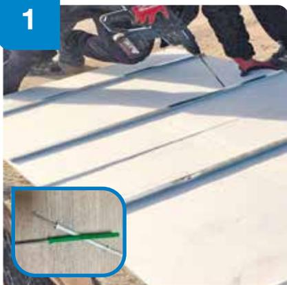
Colocar la barrera de vapor y, sobre ella, fijar las placas a la cubierta con las primarias apuntando a la cumbre.
