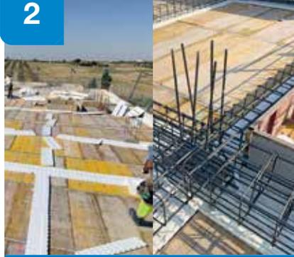
Colocación de la placa SOPRAEPS en zonas de vigas, capiteles y pilares. Colocación de armadura y esperas (si hay pilares para forjado superior) sobre las placas.
