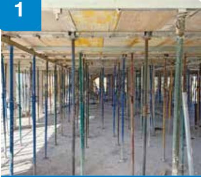
Montaje de encofrado de toda la superficie, instalación de puntales, sopandas y tableros de madera.
